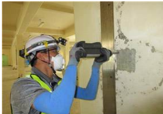
콘크리트 비파괴강도 조사
